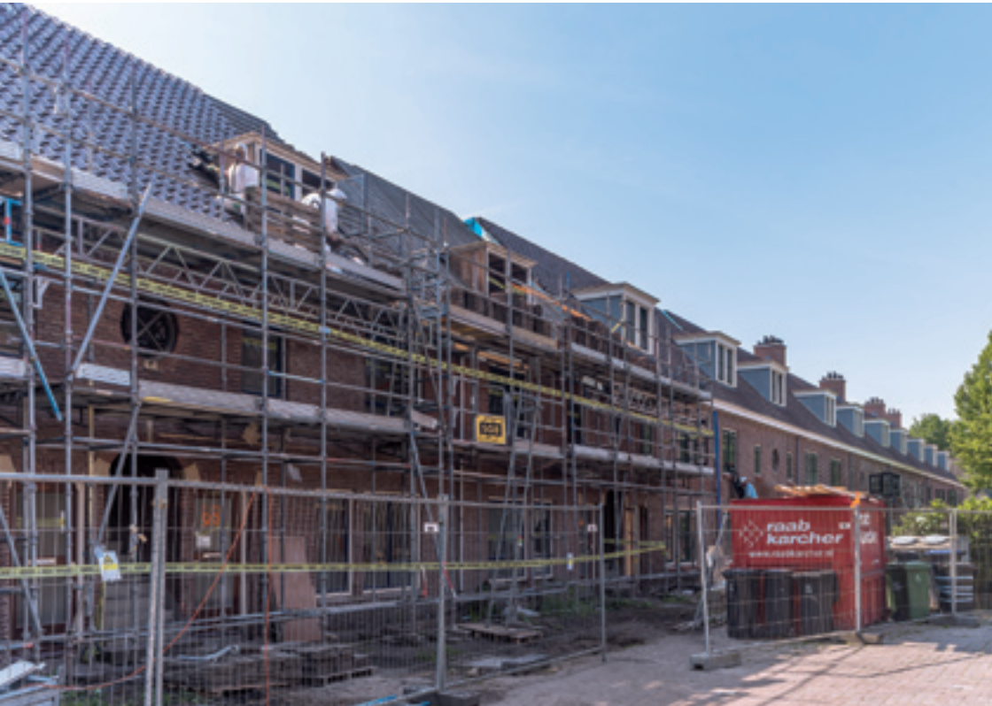
2. Bij dakrenovatie moet je ook rekening houden met zoiets als het voorkomen van asbest.
