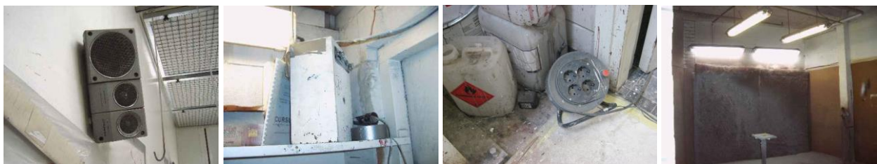
Voorbeelden van apparatuur niet geschikt voor gebruik in gezoneerd gebied m.b.t. damp
