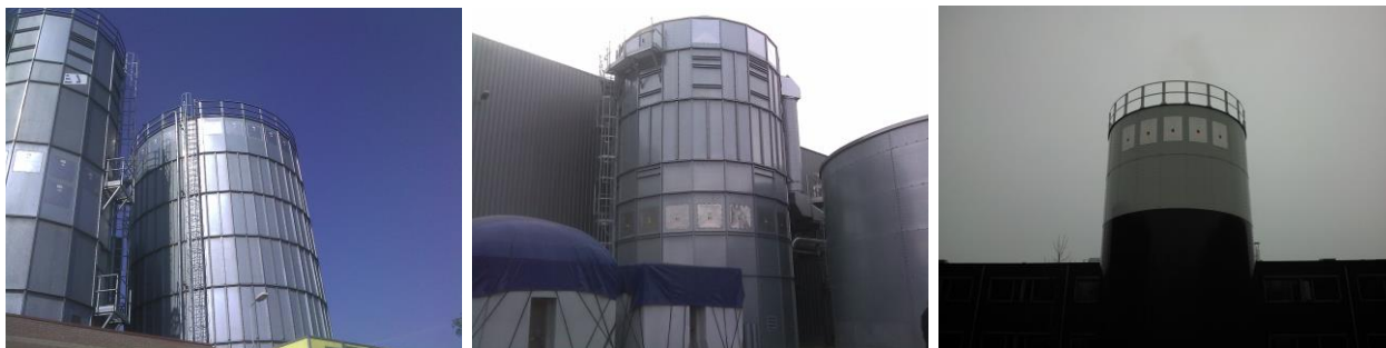
Voorbeelden van drukontlasting bij silo's
