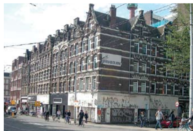
▲ Oude situatie: door verwaarlozing van bijna een decennium moest het gebouw van ver komen. Foto: NBvT.
