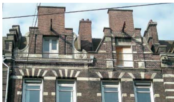
▲ Oude situatie en nieuwe: in een onbewaakt ogenblik zijn kunststof kozijnen geplaatst die het gevelbeeld geen recht deden. Foto: NBvT.
