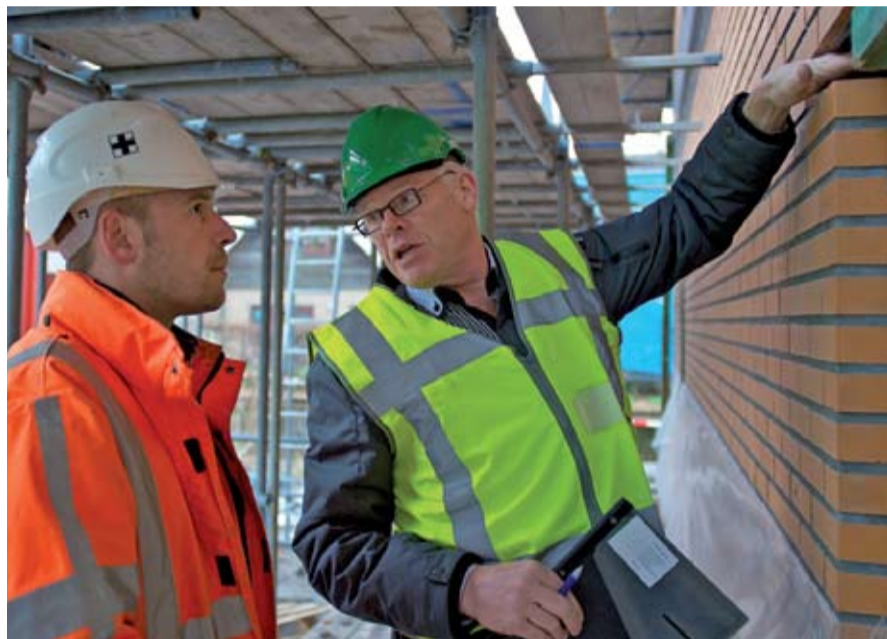
▲ De bouwplaatsinspectie is de basis voor verlenging van de garantietermijn. De situatie ter plekke levert waardevolle aanwijzingen op voor het succesvol toepassen van geveltimmerwerk.
